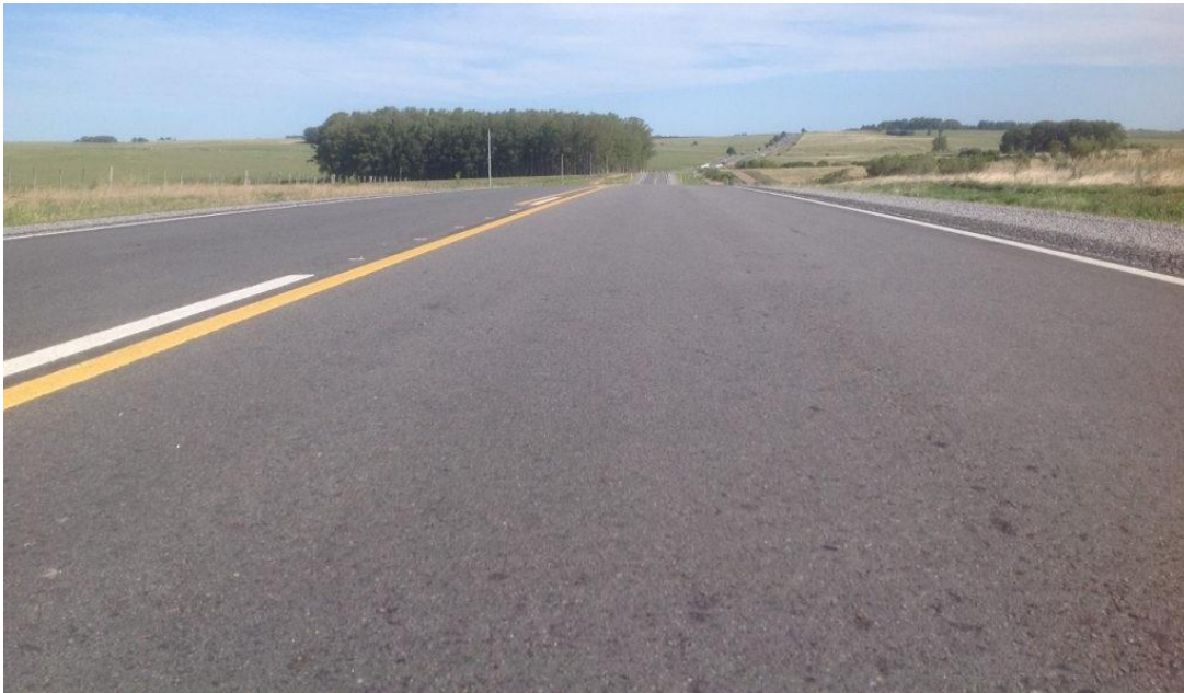
R3: Tramo con asfalto espumado + capa superior de CAC de 5 cm
