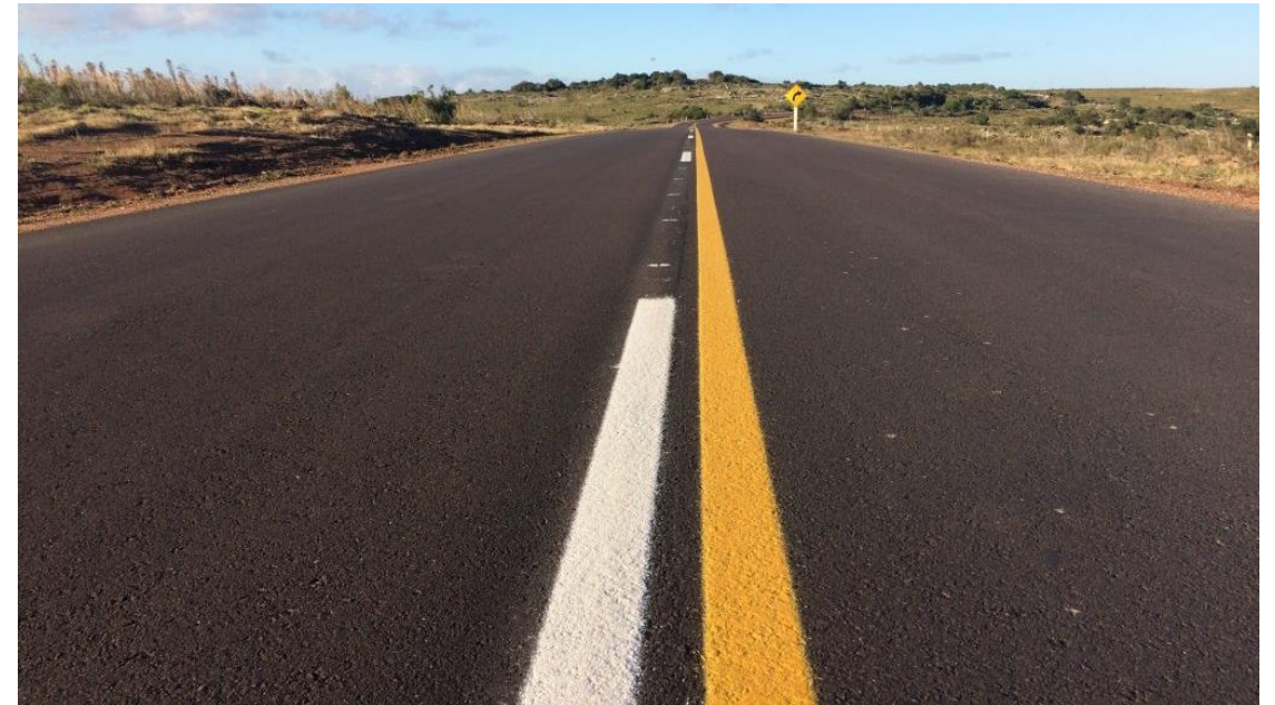
R39: Tramo con reciclado en frío con cemento Portland + capa asfáltica de rodadura
